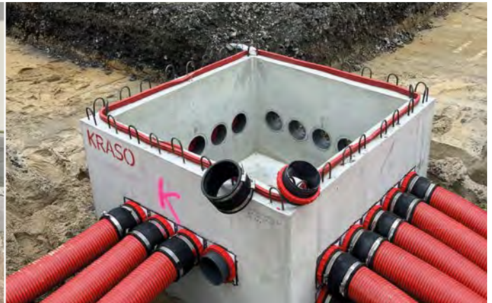
Mit individualisierten Abdichtungs-lösungen wie hier einem Pumpensumpf als Beton-Fertigteil lassen sich auch bei Großprojekten Zeit und Geld sparen
