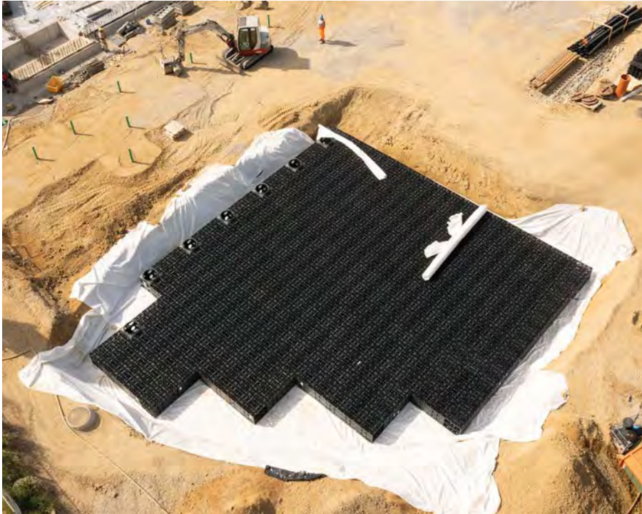
Das modulare System bietet die Möglichkeit, die Regenrückhalteanlage entsprechend den örtlichen Gegebenheiten individuell und platzsparend anzupassen
