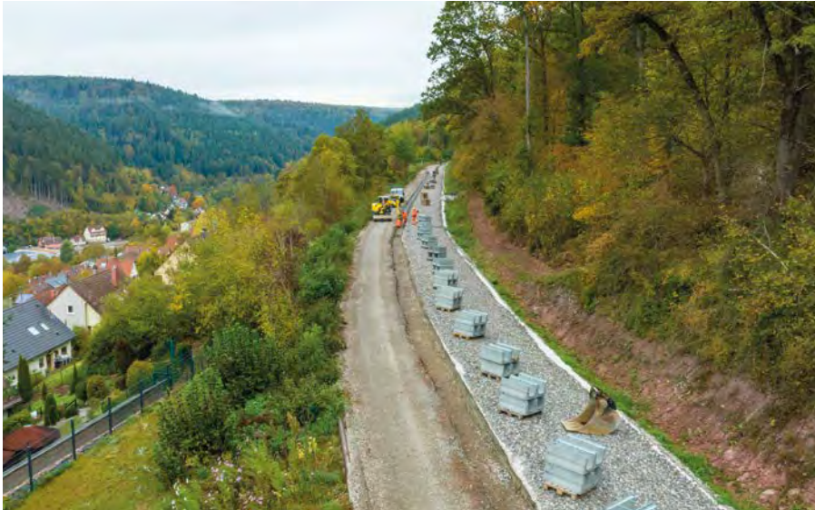
Über 1.000 Meter der BIRCOsir® werden an der malerischen Strecke der neuen Hermann-Hesse-Bahn verbaut
