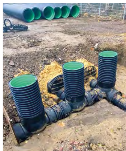
3-Strang-Stauraumkanal in Kombination mit Verteiler-Schachtelementen MULTI-inspect 600
