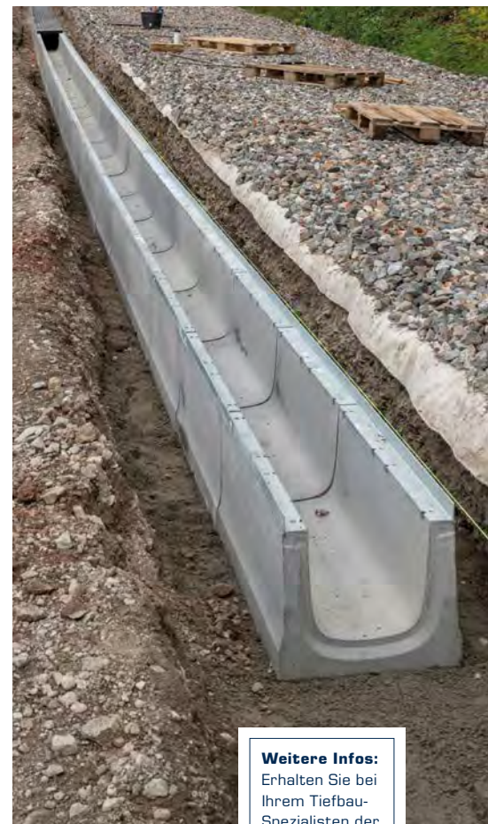
Für die Befahrbarkeit von Schwerlastfahrzeugen sorgen belastungsstabile Rinnenkörper und Hexagon-Gussplatten mit 8-facher M12/A2-Verschraubung
