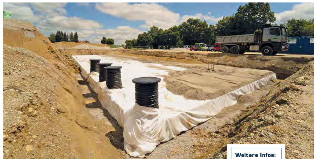
Die Schächte wurden bei GRAF bereits projektspezifisch vormontiert und anschlussfertig angeliefert
