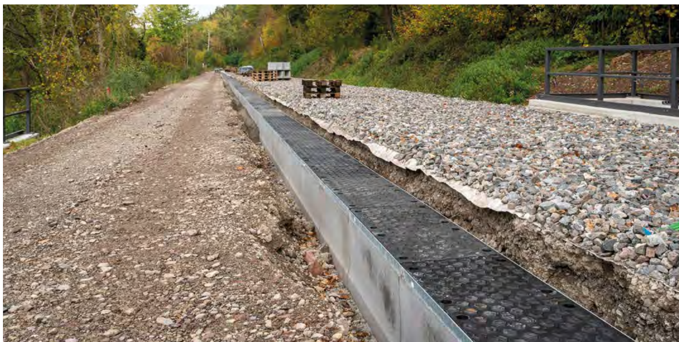
Für die Befahrbarkeit von Schwerlastfahrzeugen sorgen belastungsstabile Rinnenkörper und Hexagon-Gussplatten mit 8-facher M12/A2-Verschraubung
